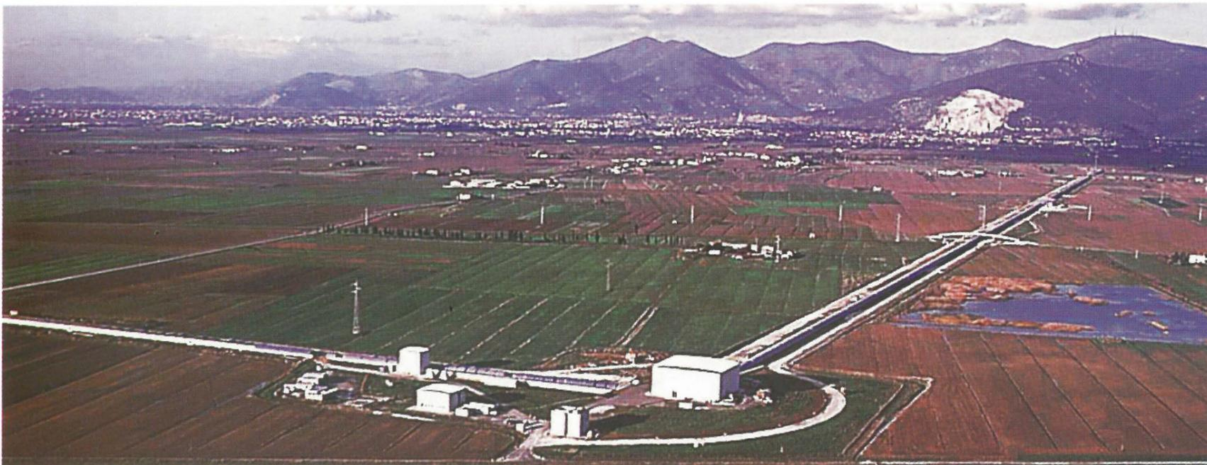
*Virgo : ce détecteur d'ondes gravitationnelles installé près de Pise est une enceinte à vide constituée de 2 bras longs de 3km. Cet instrument rassemble de nombreuses technologies de pointe.*
